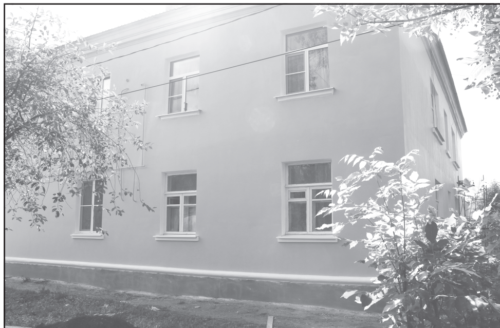
Дом № 15 по улице Первомайской после ремонта
