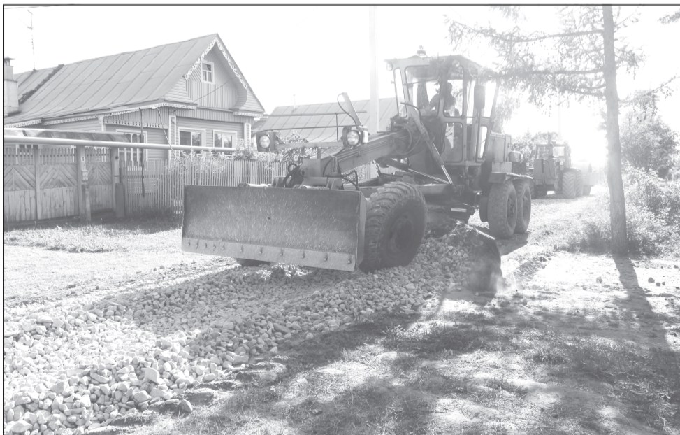
Ремонтные работы на улице Новая
